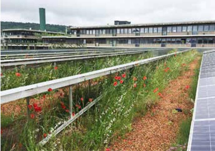
Dachbegrünung und Solarstromproduktion
