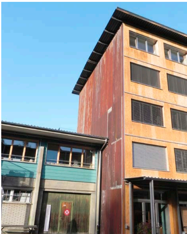
Bedachung für LKW wird zur Fassadenver- kleidung © Stefan Ineichen
