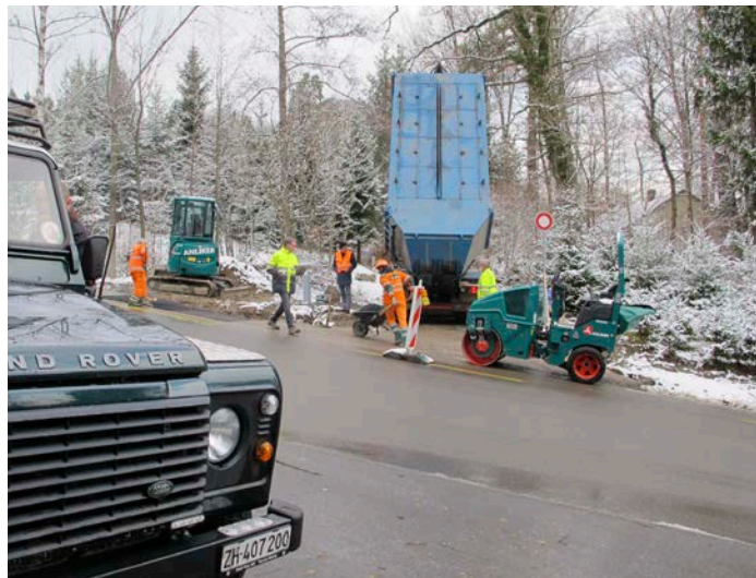
Warnanlage im Bau © Stefan Hose
