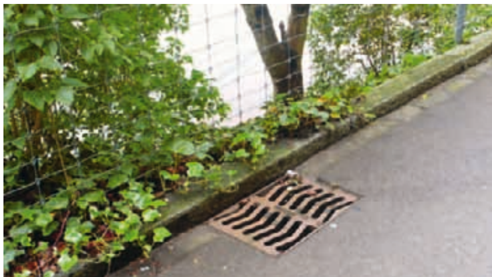
Schacht und Randstein mit Leitwirkung am Waldrand Orellistrasse.
